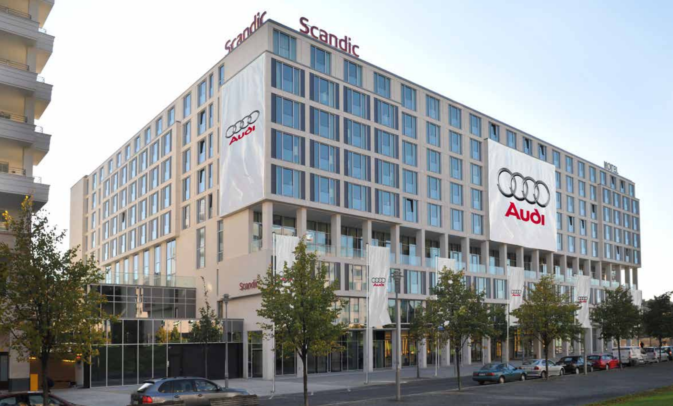
Fassadenbanner seitlich (Richtung Potsdamer Platz oder Gleisdreieck), Fassadenbanner (Haupteingang) Fahnenmasten
